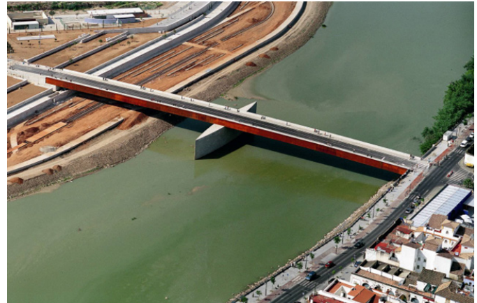
Figure 4: “Puente de Miraflores” over the Guadalquivir River, Spain. Source: courtesy Julio Martínez Calzón.
